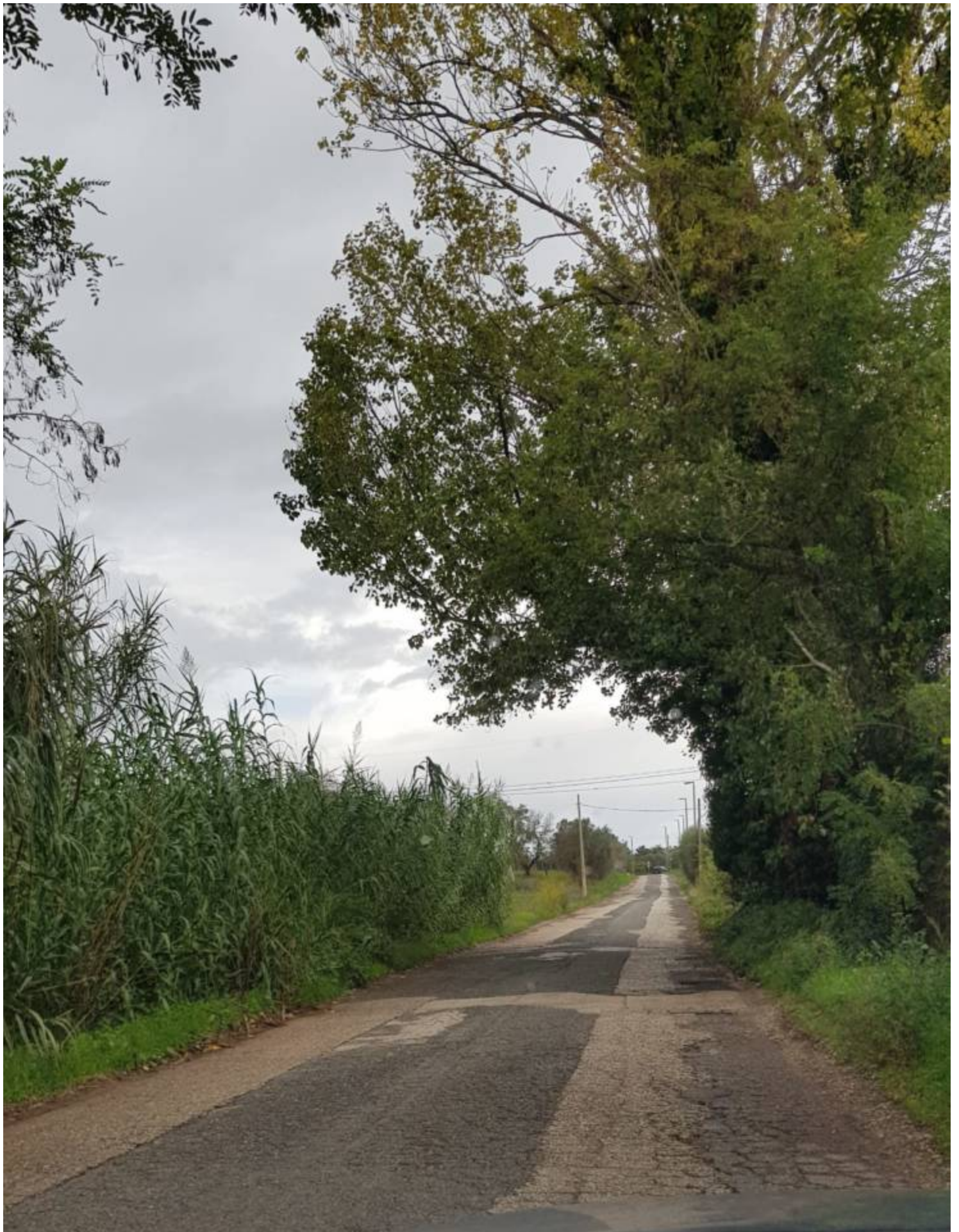
Buratti Italia Viva Pomezia "Emergenza fognatura in via delle
