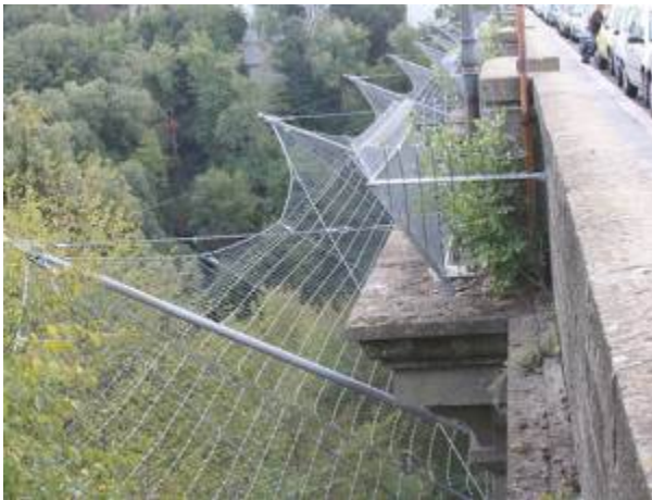
Ponte di Ariccia
