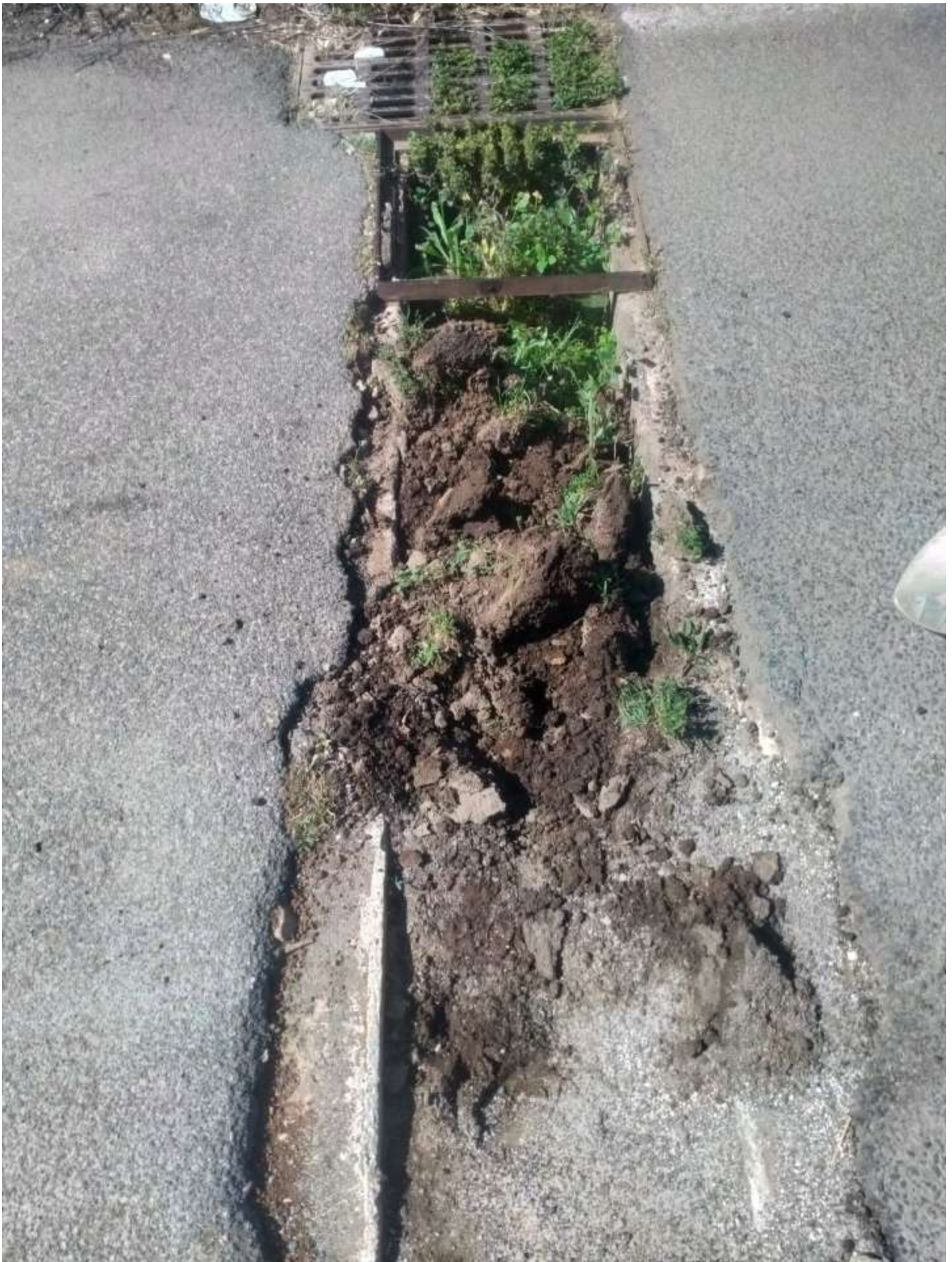
Terminati i lavori di manutenzione stradale in via Acquaviva e via
