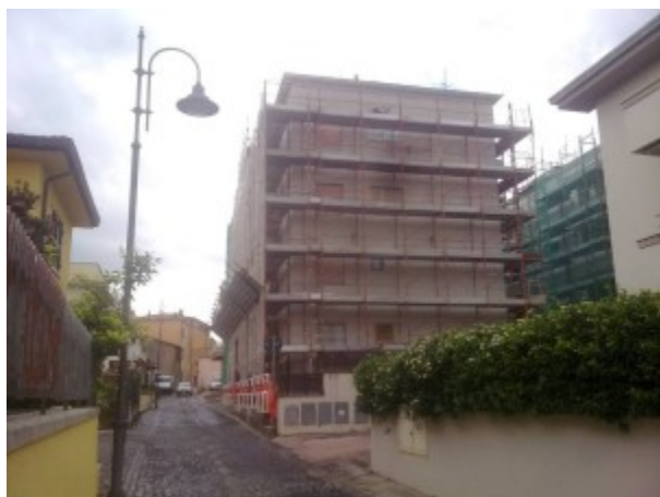
Lavori sugli alloggi comunali a Lariano
