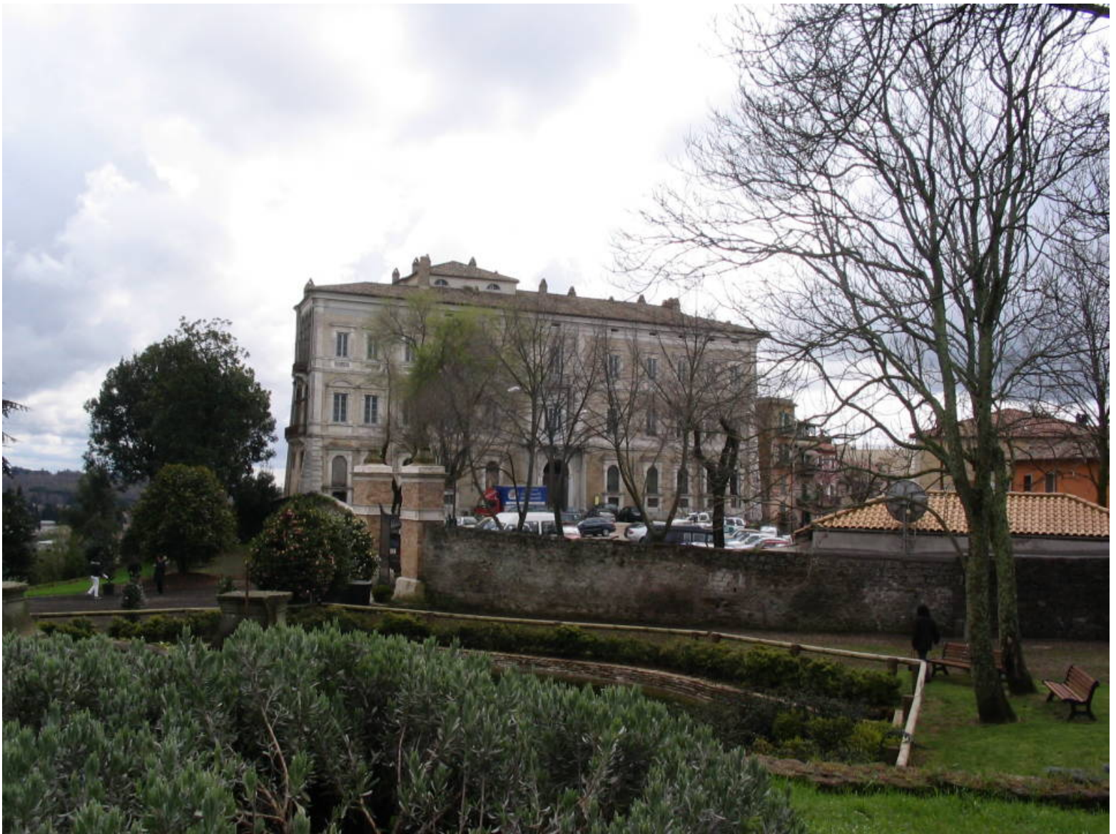
Genzano, intervento sperimentale a Palazzo Sforza Cesarini per il prosciugamento delle murature
