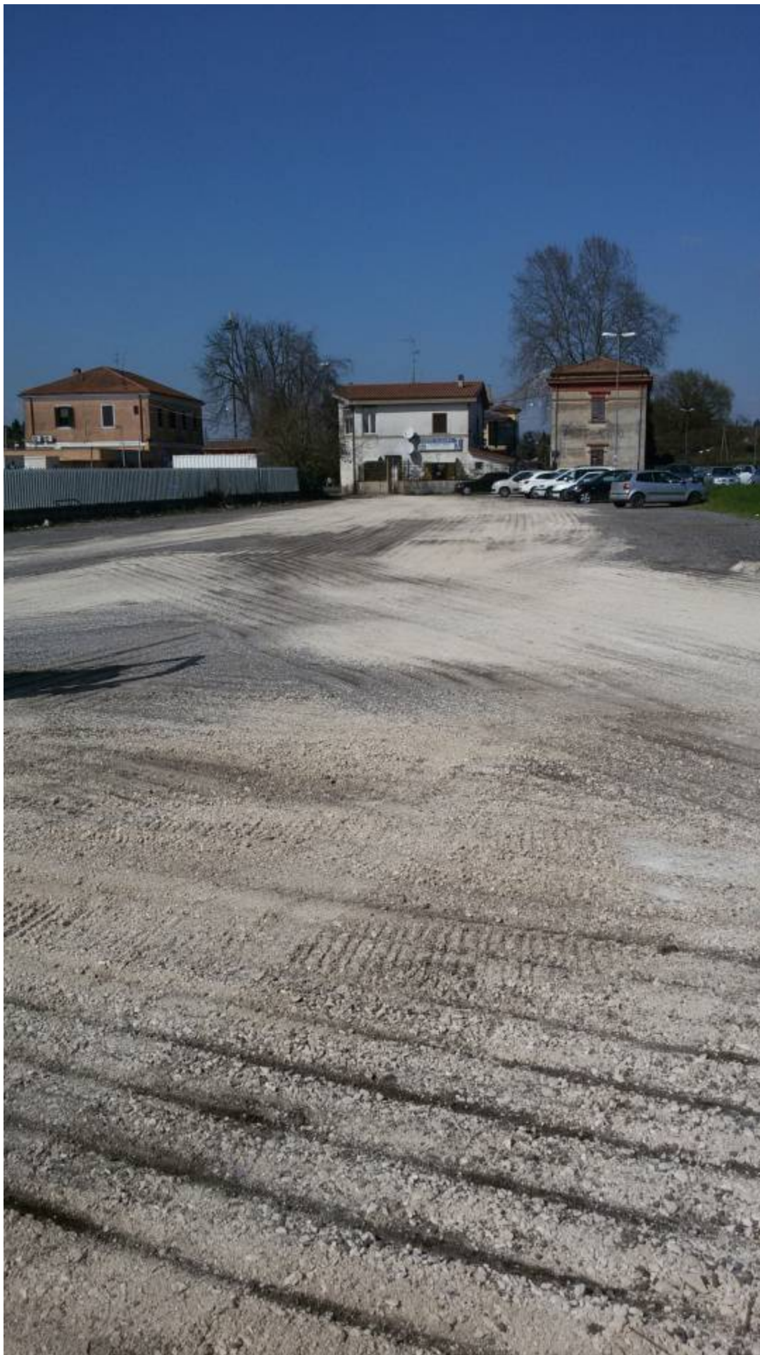
Lavori Piazzale Stazione Zagarolo
