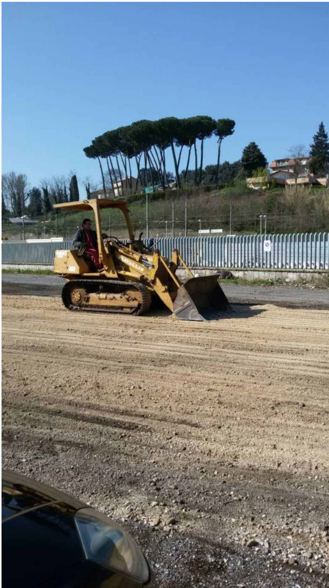
Lavori Piazzale Stazione Zagarolo
