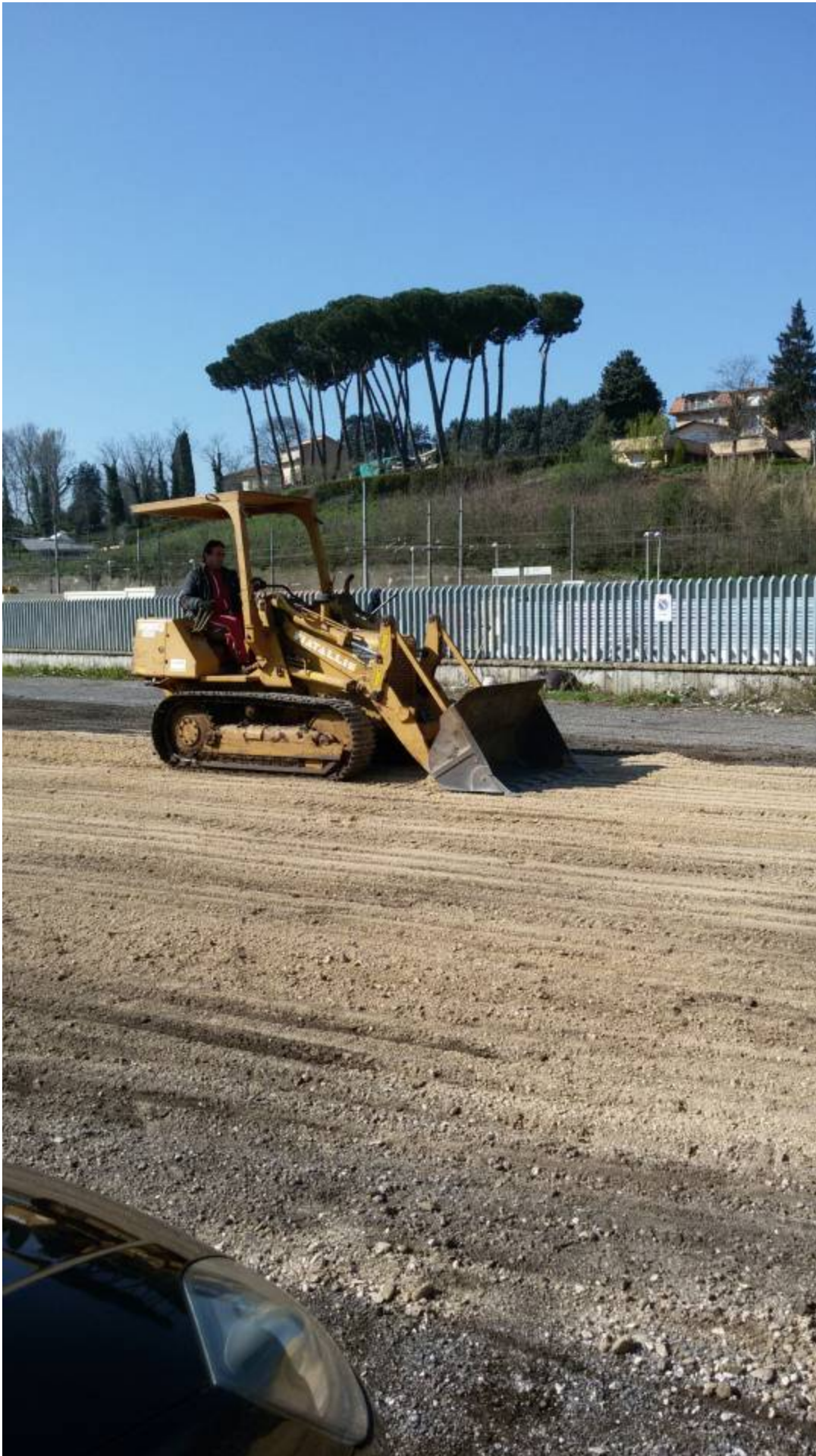
Interventi di manutenzione straordinaria sul Piazzale della Stazione di
