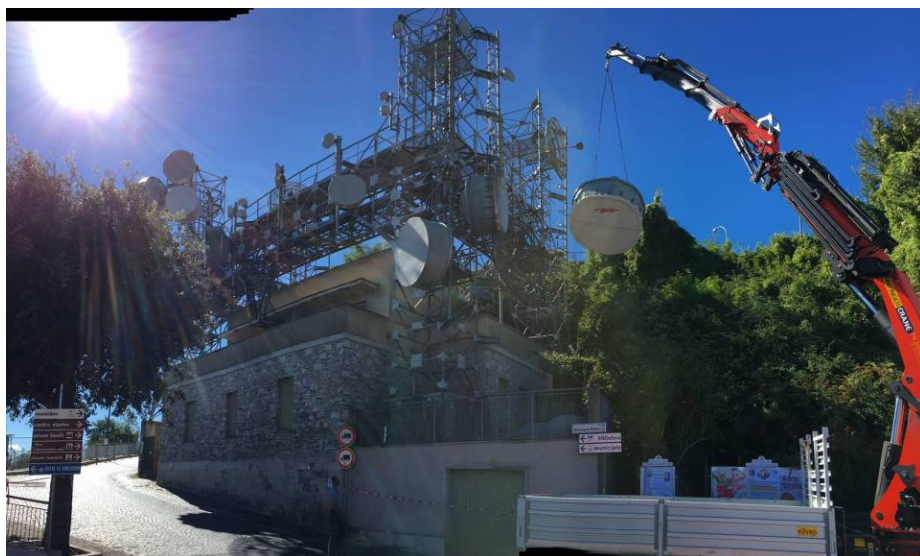
Rocca Priora, in corso la dismissione degli impianti di Via Monsignor Giacci
