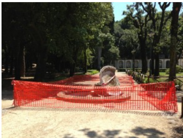
La fontana di Villa Torlonia distrutta dai vandali il 16 giugno 2013.
