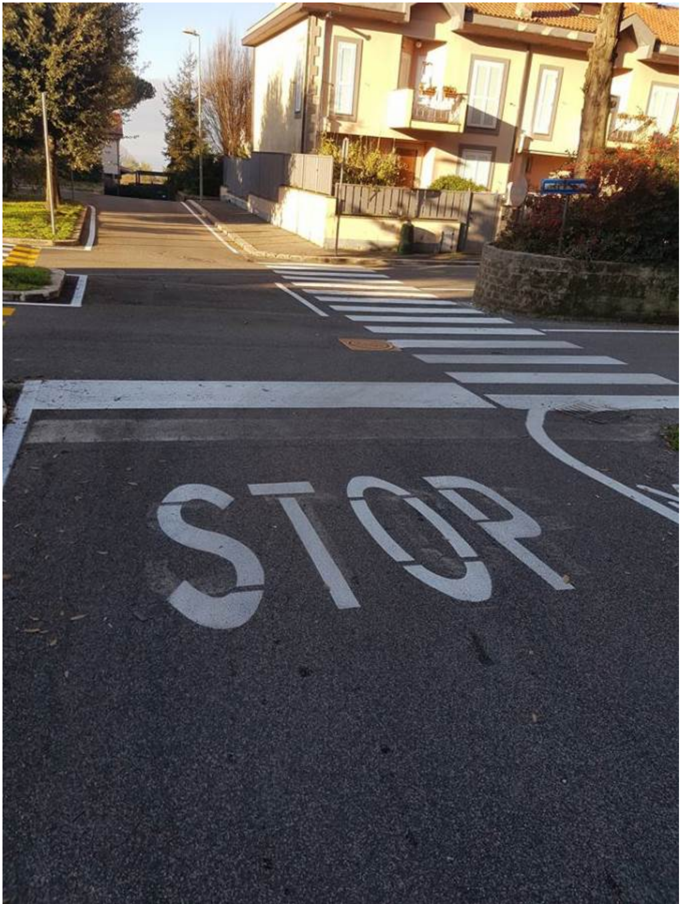
Nemi, continuano lavori per la sicurezza stradale
