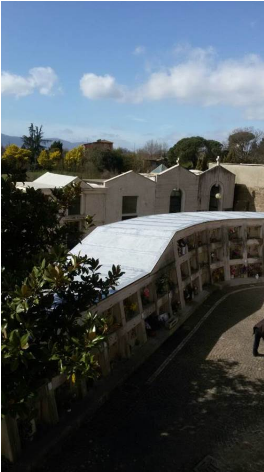
Zagarolo, manutenzione loculi cimitero comunale
