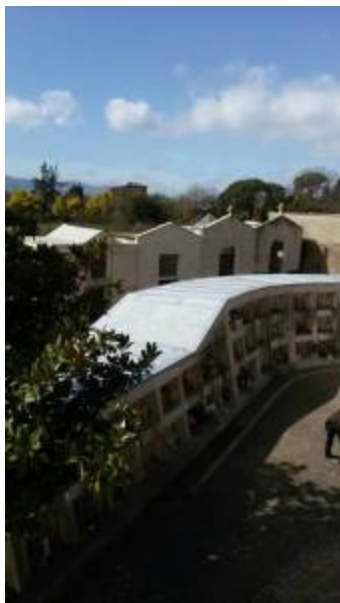
Manutenzione al cimitero di Zagarolo
