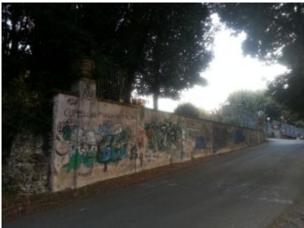
Degrado di Villa Sciarra a Frascati
