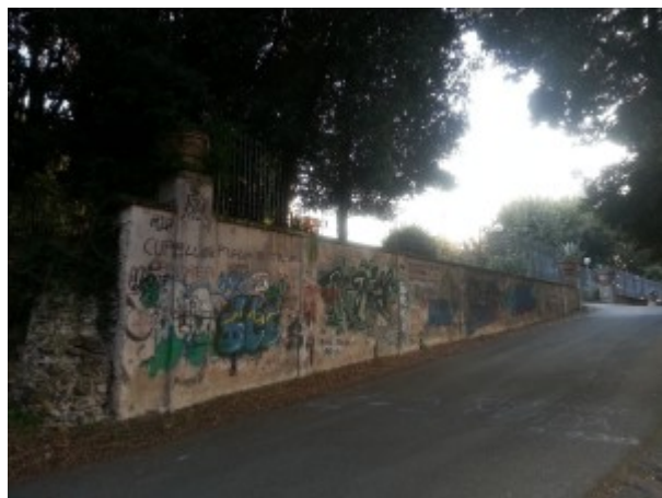
Degrado di Villa Sciarra a Frascati
