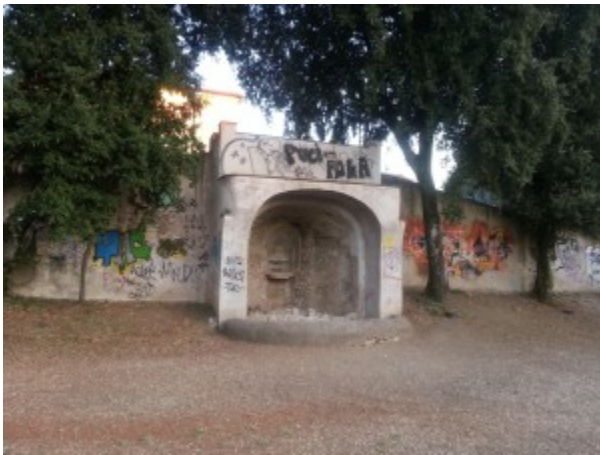
Degrado a Villa Sciarra di Frascati
