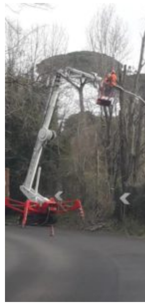
Lavori per la sicurezza stradale di Nemi
