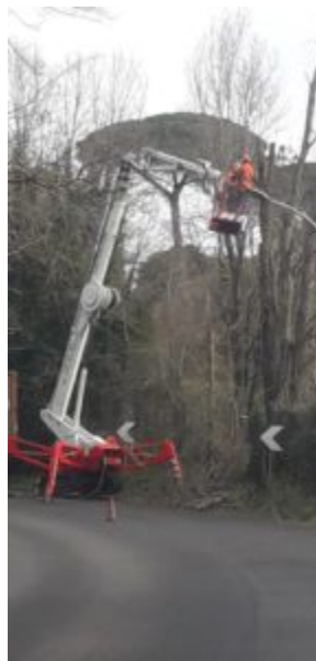
Lavori per la sicurezza stradale di Nemi
